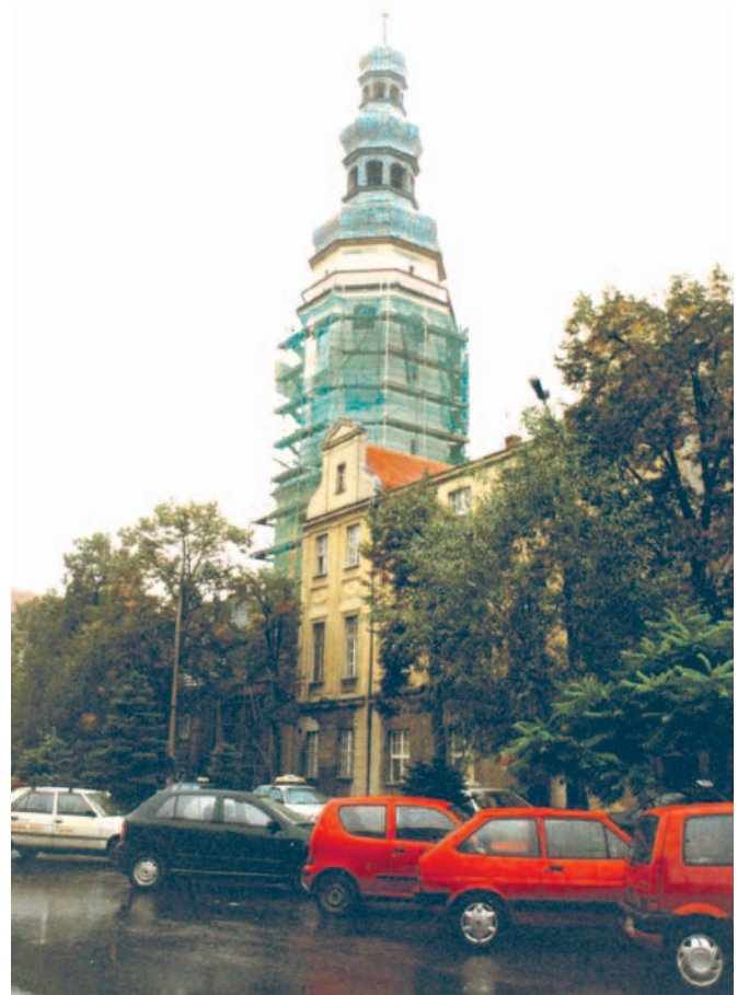
Zdjęcie z archiwum „Gazety Powiatowej”, zrobione w 2002 roku, w trakcie remontu wieży ratuszowej. Piękne dorosłe lipy zasłaniają ratusz, który wtedy był jeszcze przed remontem, więc na szczęście nie widać uszkodzonych tynków
