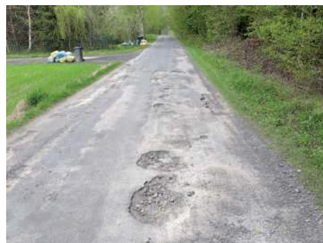
Remonty mają ruszyć jeszcze tym roku
