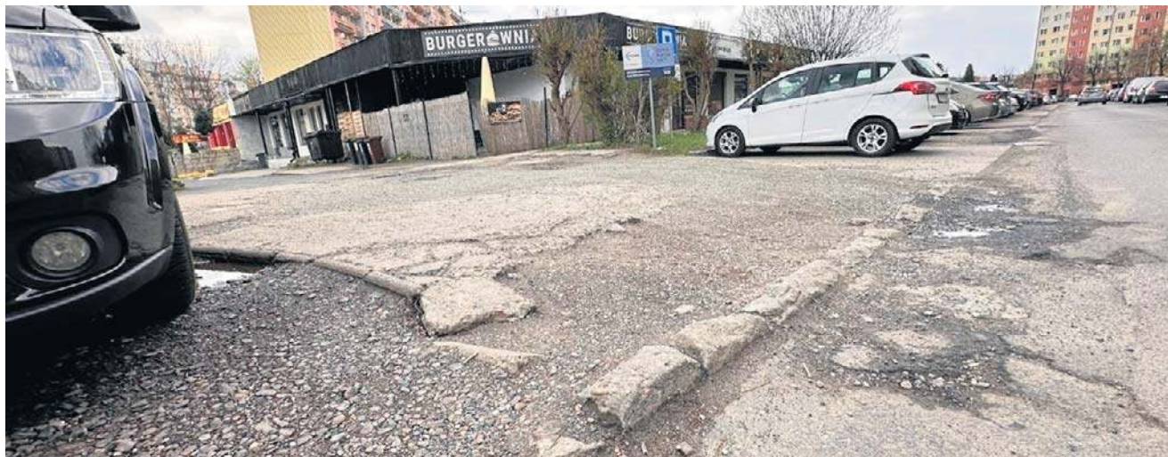
Ulica Hetmańska od dawna wymagała remontu. Teraz zostanie na niej przebudowany odcinek, liczący 631 metrów.
