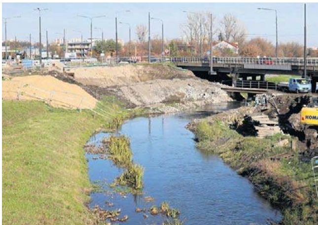
Roboty drogowe przy al. Unii Lubelskiej idą zgodnie z harmonogramem. Wykonano 10 procent prac
