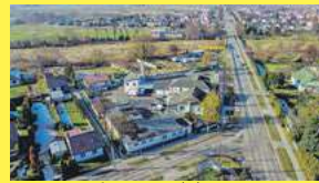
Nieruchomość przemysłowa w Międzyrzecu Podlaskim z istniejącą hurtownią spożywczą i stacją gazu LPG, przy ulicy Warszawskiej, blisko wyjazdu na drogę E 30 (krajowa A2), 665 750 197
