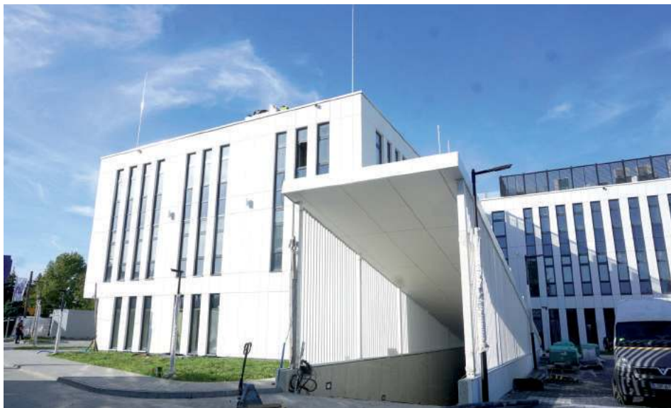
Nowy gmach Sądu Rejonowego i Prokuratury Rejonowej w Opolu Lubelskim ma zostać oficjalnie otwarty w czerwcu 2024 r. Obecnie trwa wykańczanie wnętrza budynku
