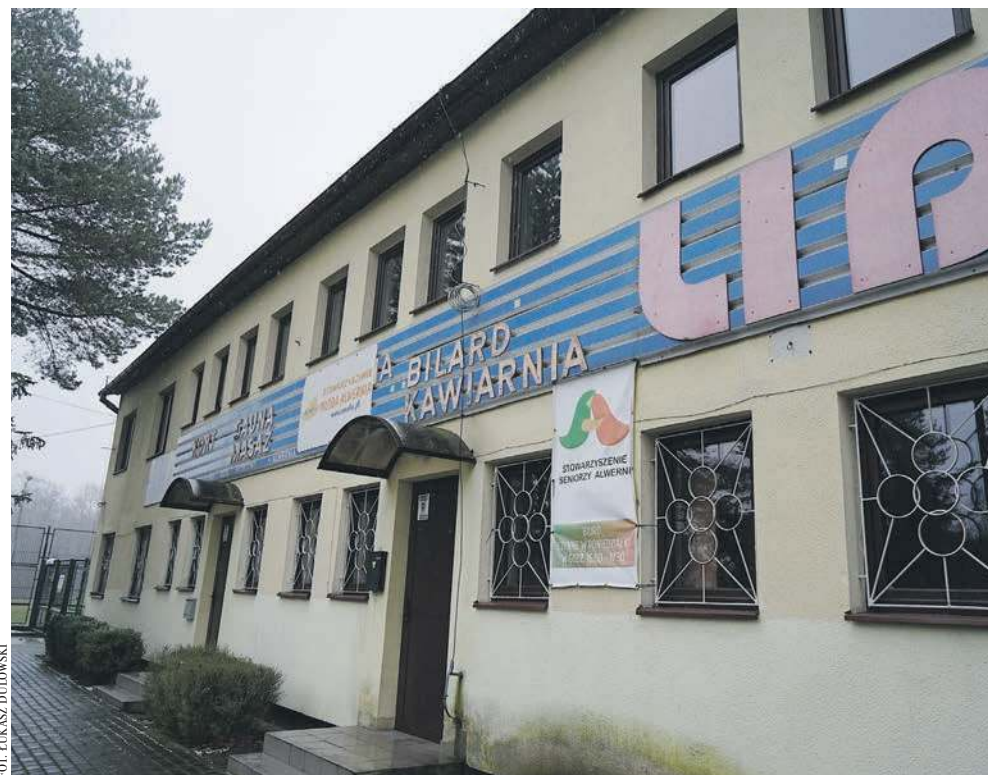
Budynek na stadionie przy ul. Zięby w Alwerni ma za sobą czasy świetności
