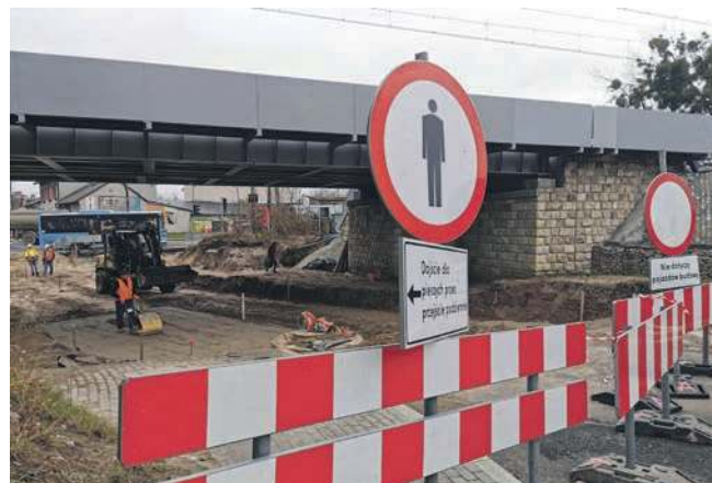
Wiadukt nad ul. Krakowską
