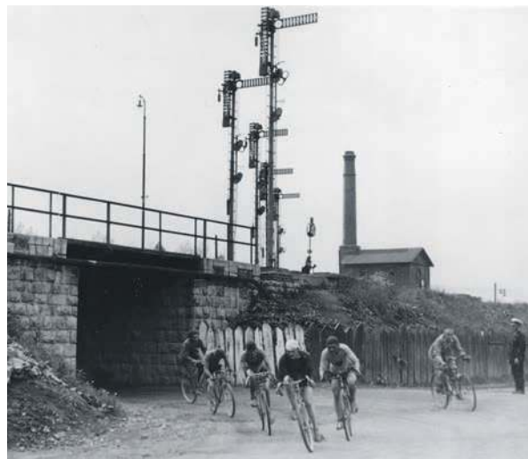
Kolarze przy wiadukcie w Trzebini w 1932 r.
