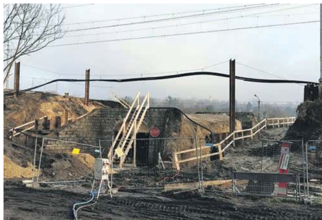
Wiadukt nad ul. Krasickiego
