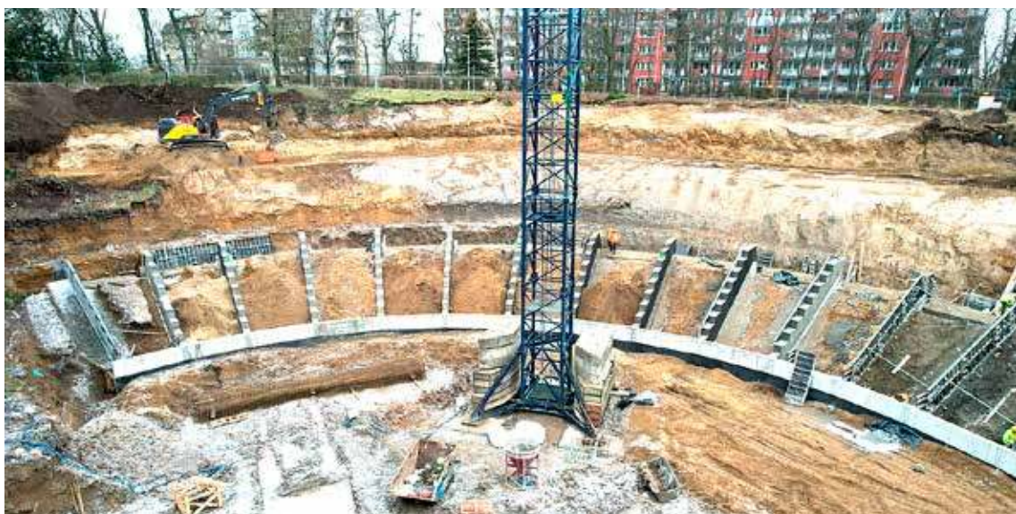
U podstawy widowni wykonano ścianę oporową. Wyraźnie widać już też pierwszy rząd
