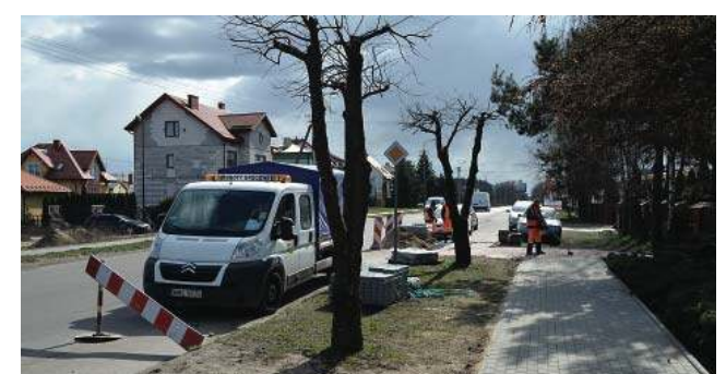
Już niedługo nowy chodnik na ul. Płockiej
