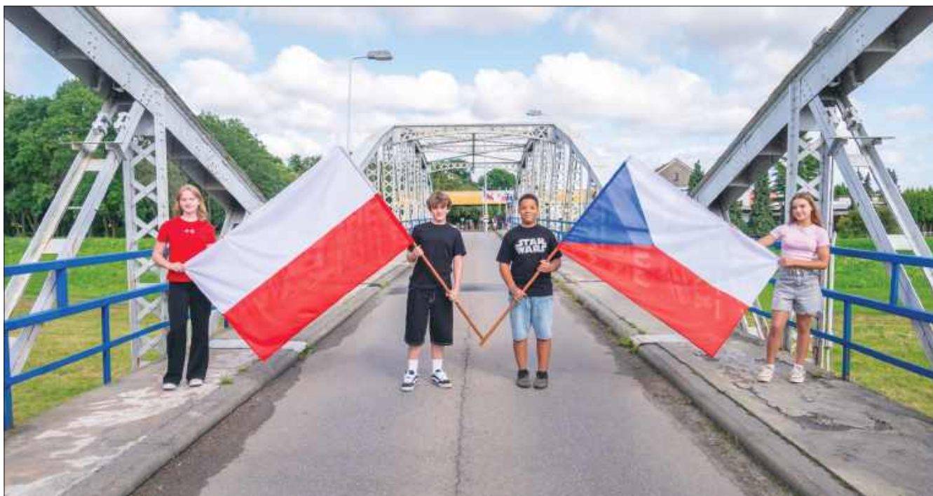
■ Polska i Czechy razem modernizują graniczny most. Remont zaplanowano na lata 2026 – 2027. FOT. UG KRZYŻANOWICE
