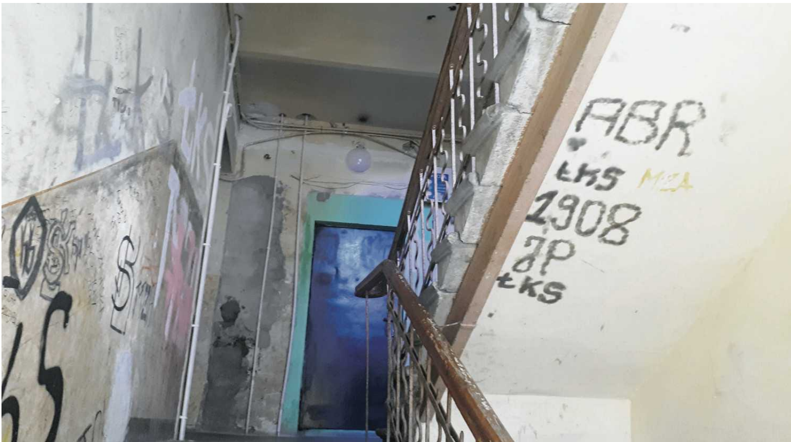
• Klatka schodowa kamienicy przy ul. Abramowskiego FOT. MAŁGORZATA SZLACHETKA
