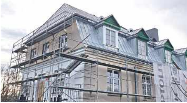
Obecnie ekipy budowlane koncentrują się na pracach wykończeniowych oraz instalacyjnych na poddaszu szkoły
