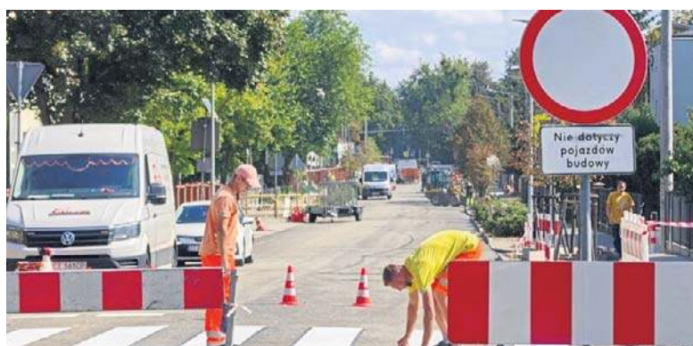
Remont Żwirki i Wigury jest na finiszu
