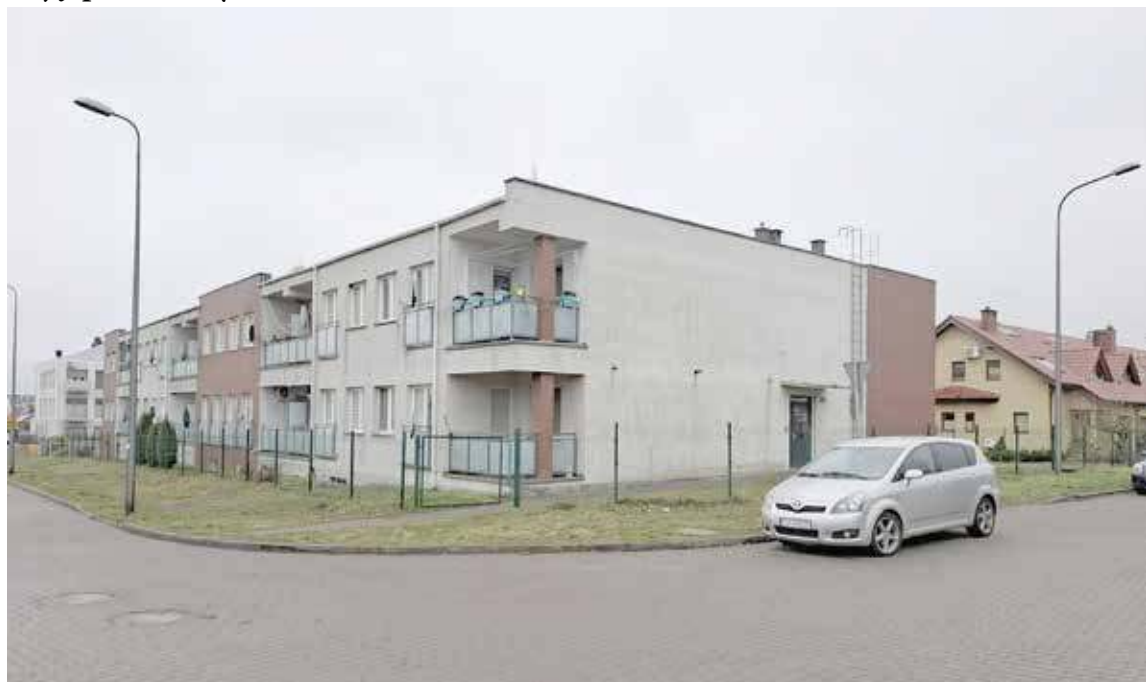
Radny wnioskuje m.in. o uzupełnienie chodnika przy bloku nr 5 u zbiegu Niepodległości i Witkiewicza
