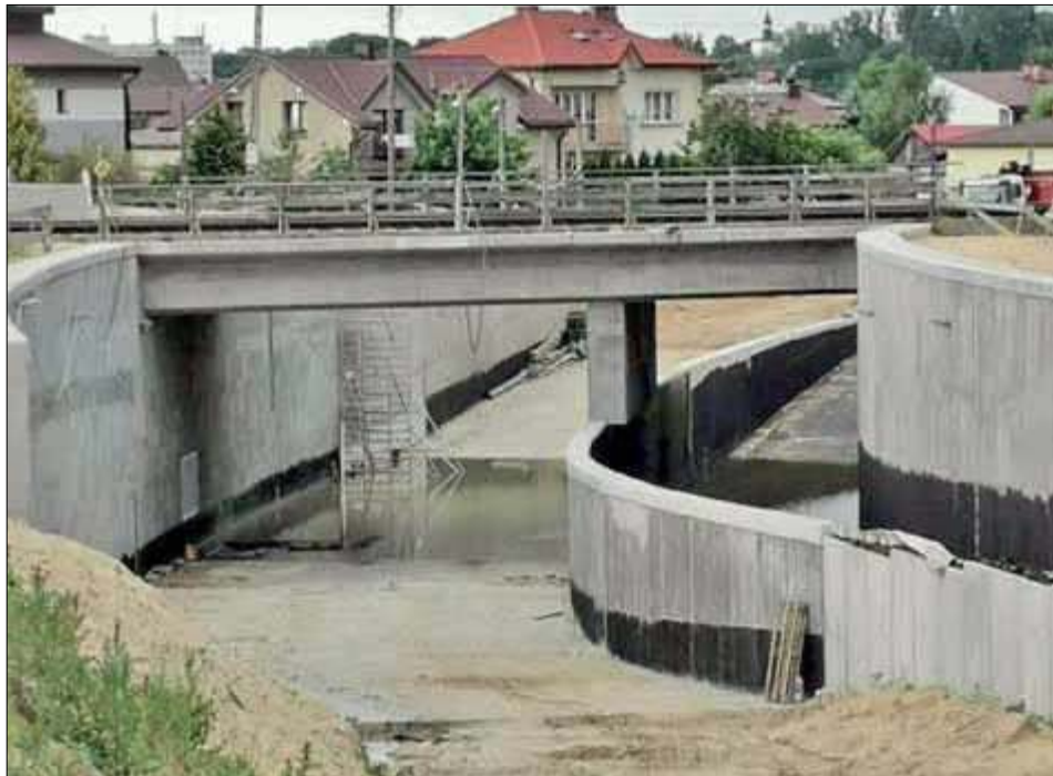
10 sierpnia wykonawca przerwał prace przy dojazdach do tunelu, bo energetycy rozpoczęli przenoszenie linii napowietrznej. Wcześniej okazało się, że trzeba przeprojektować lokalizację przepompowni, odprowadzającej wodę spod wiaduktu
