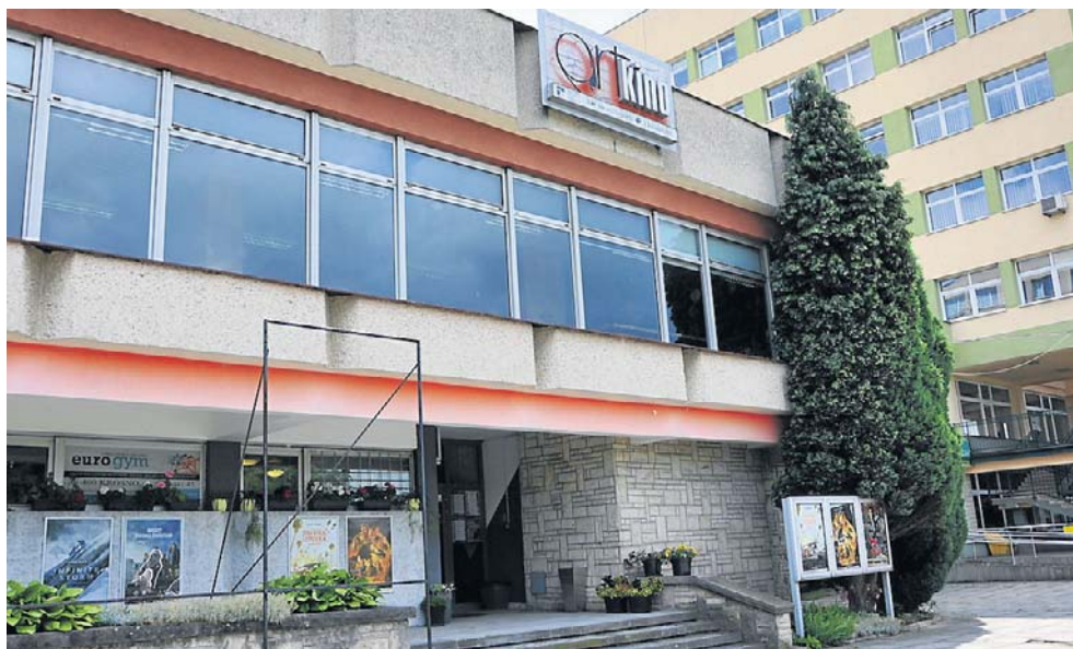
Miejskie kino już zostało zamknięte. Wykonawca: krośnieńska firma KK-Budma pięć miesięcy na zakończenie robót
