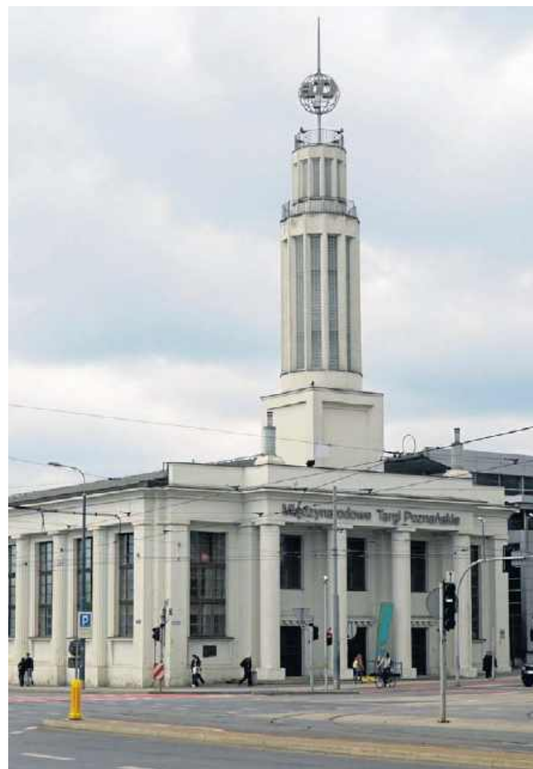
„Iglica” - symbol dzisiejszych Targów, wykorzystuje elementy konstrukcyjne Wieży Górnośląskiej
