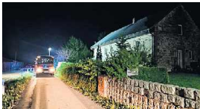
W Pietrzykowie w powiecie kaliskim doszło do rozszczelnienia instalacji gazowej i wybuchu butli.
