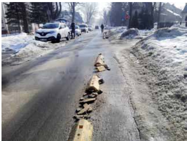
Zniszczone separatory w al. Solidarności.
