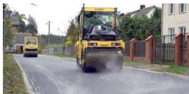
Budowa nawierzchni asfaltowej na osiedlu w Sarnowie
