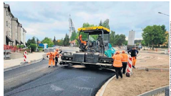
Rozbudowa ulicy Reja w Wągrowcu. Jak przebiegają prace?
