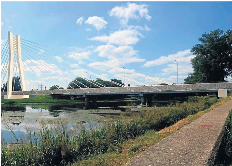
Tak ma wyglądać kładka przez Prosnę wzdłuż Szlaku Bursztynowego.
