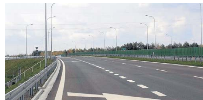
Budowa obwodnicy Kalisza. Zapadła ważna decyzja w tej sprawie.
