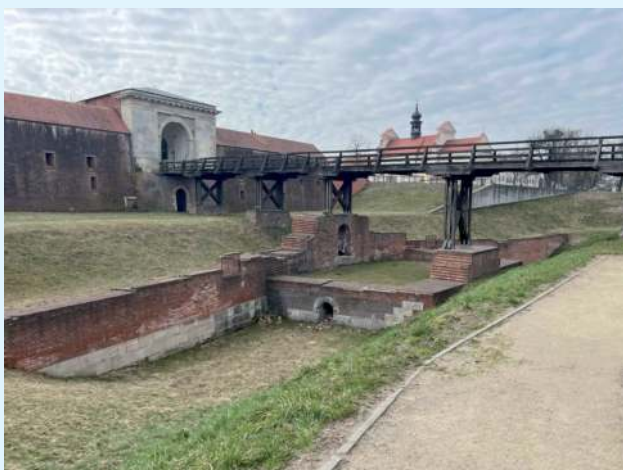
Firma, która wygra postępowanie i podpisze umowę z samorządem, otrzyma 6 miesięcy na wykonanie wszelkich prac na moście w Zamościu
