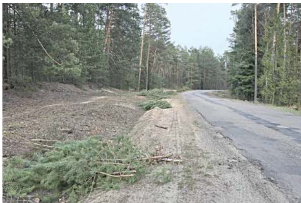
Rozpoczęły się pierwsze prace. Droga będzie gotowa za kilka miesięcy
