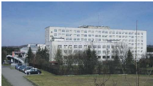
FOT. Z ARCHIWUM Za budynkiem szpitala mogłoby powstać dodatkowe skrzydło
