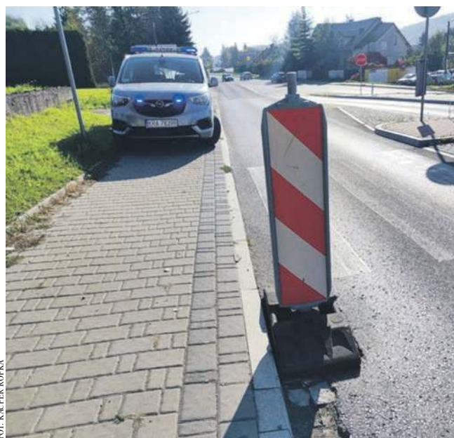
Zabezpieczona tymczasowo kratka kanalizacyjna
