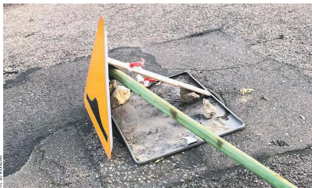
Miejsca po skradzionych włazach zabezpieczono, by nie stwarzały zagrożenia dla przechodniów
