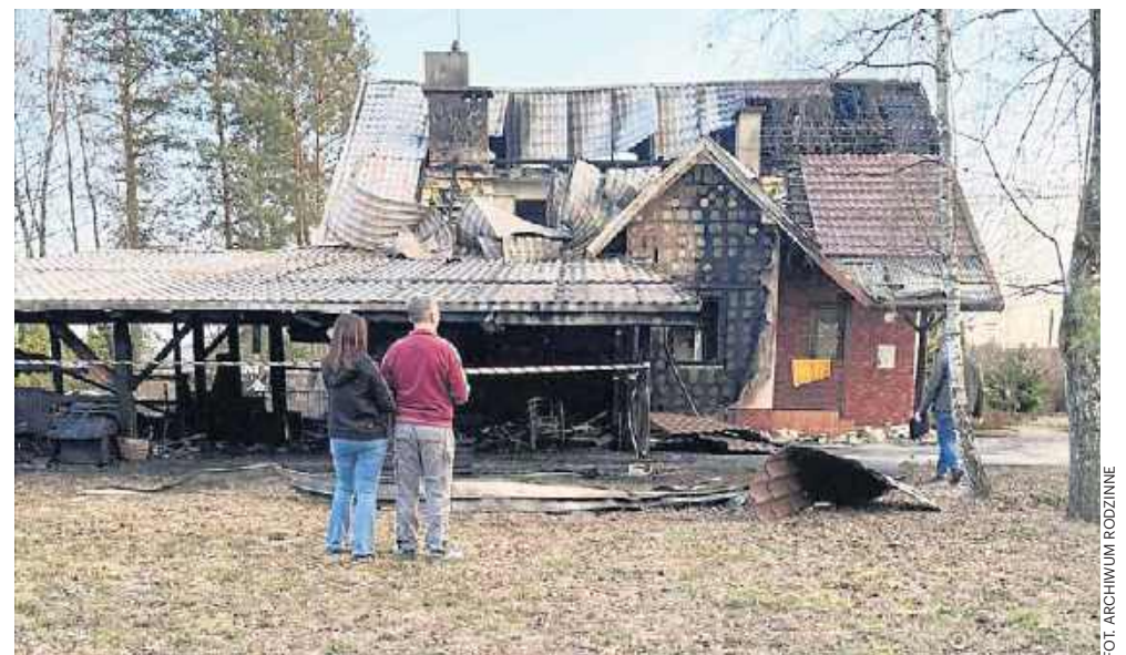
Budowany latami dom w Mokrzyskach nie nadaje się obecnie do zamieszkania
