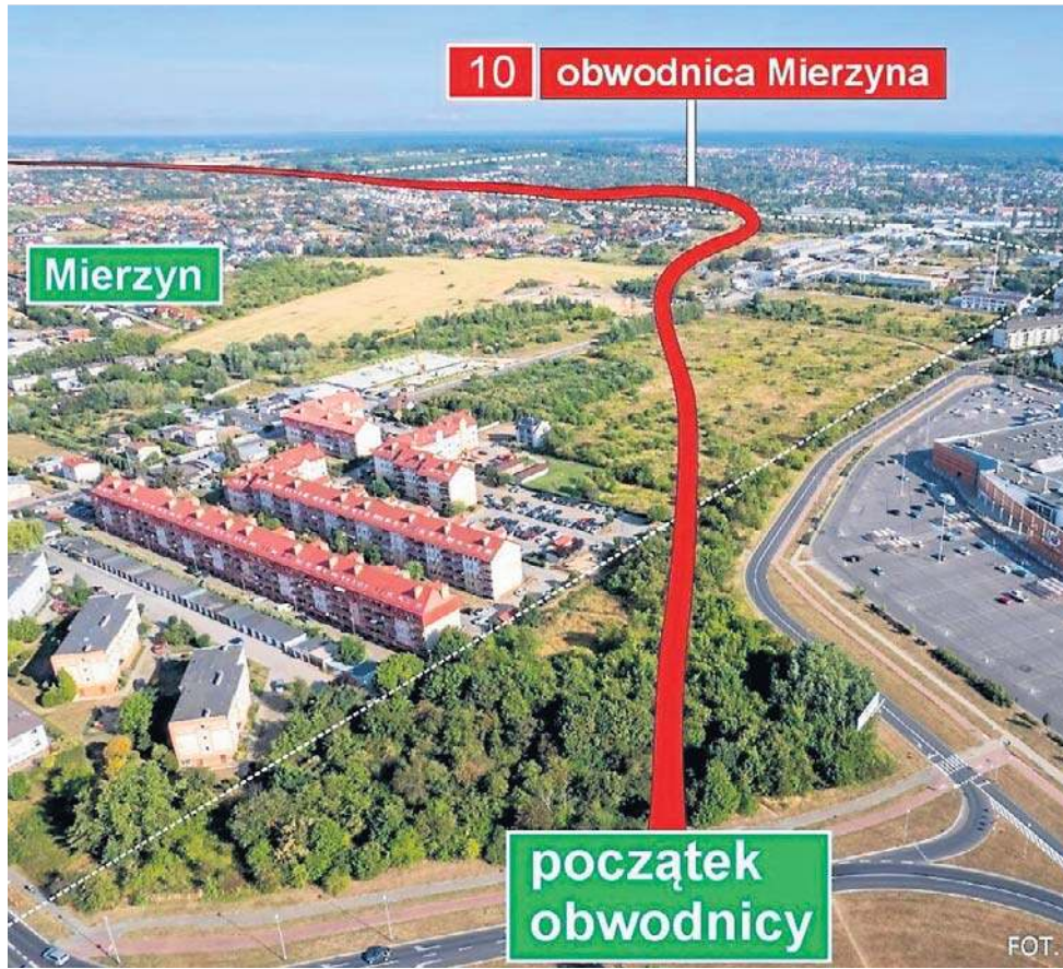
Początek obwodnicy na pograniczu Szczecina i Mierzyna
