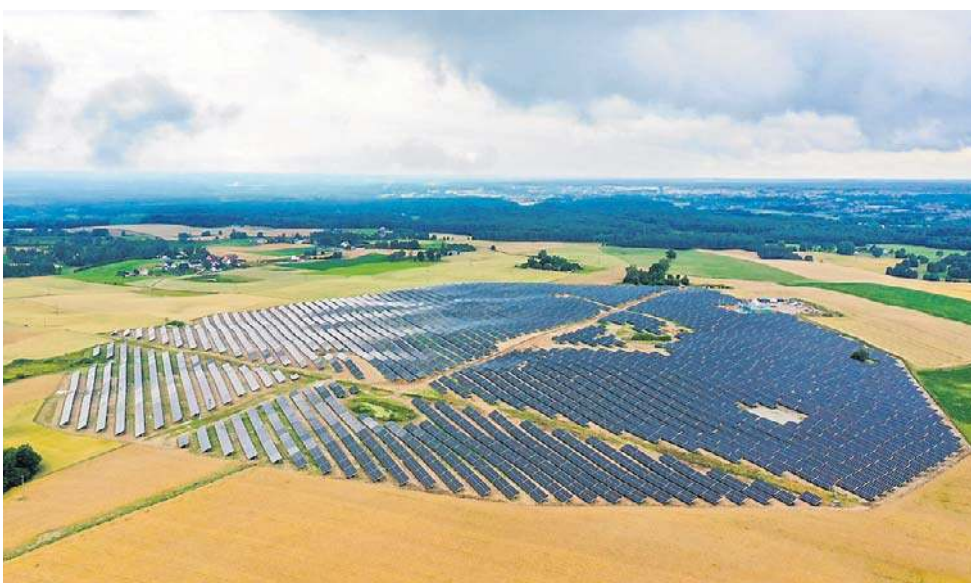
Powstająca na Pomorzu farma fotowoltaiczna PV Łosienice
