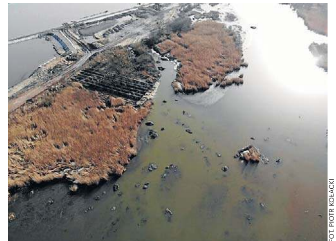
Zdjęcia z lutego 2021 roku, stan Łarpi po awarii rurociągu
