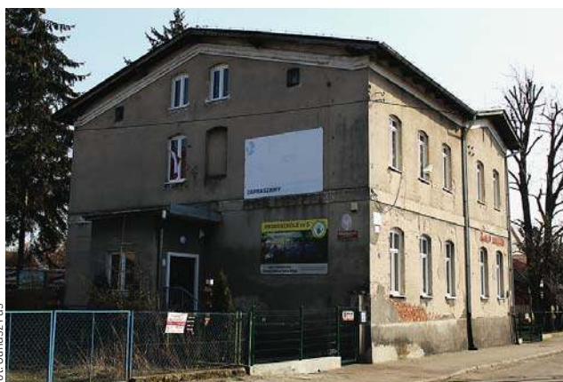
Budynek Przedszkola nr 5 przy ul. Szańcowej również nie spełnia norm w zakresie ochrony przeciwpożarowej
