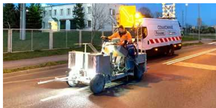
Slużby drogowe odświeżają oznakowanie na drogach.j
