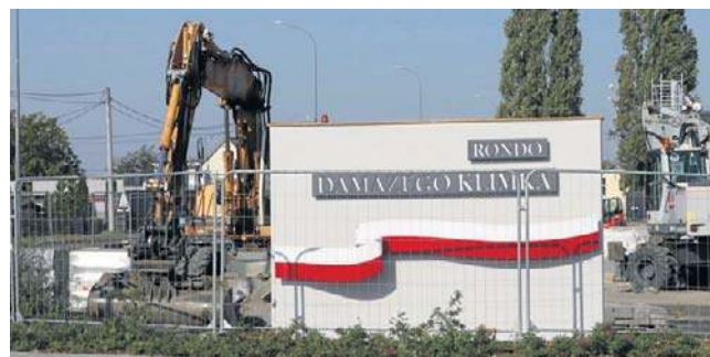
Budowa ronda i ulicy jeszcze trwa, ale tablicę informującą o patronie już ustawiono
