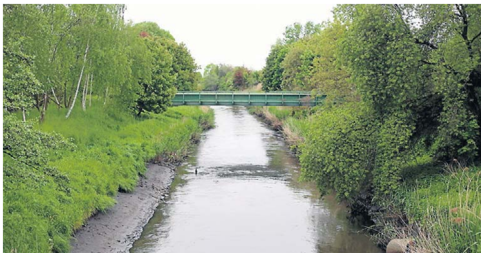
Pierwszy etap budowy trasy rowerowej wzdłuż rzeki Kłodnicy coraz bliżej
