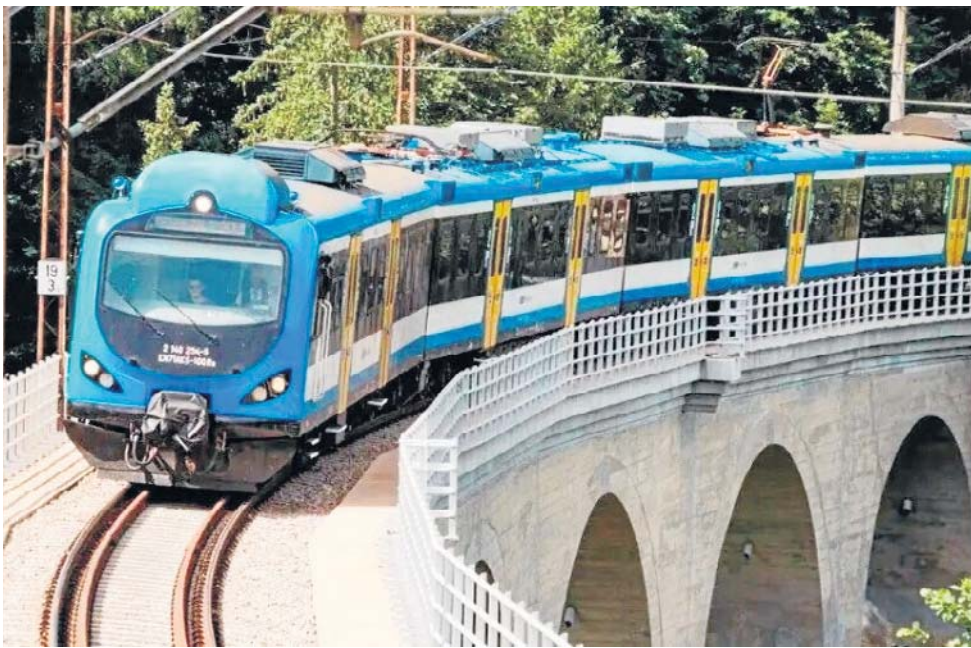
Mieszkańcy walczą o domknięcie beskidzkiej pętli kolejowej, która ułatwiłaby im życie
