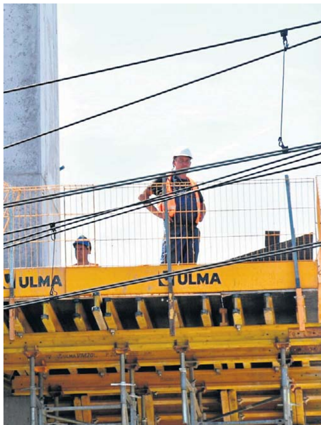
Budowa wiaduktu idzie zgodnie z harmonogramem
