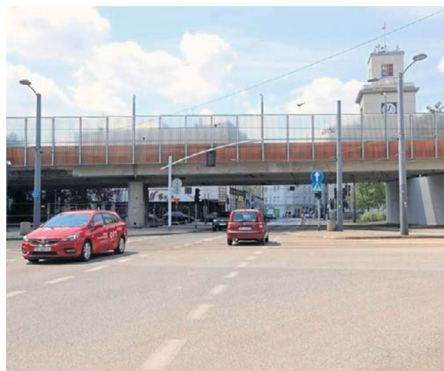
Nadal trwają roboty naprawcze w tym rejonie
