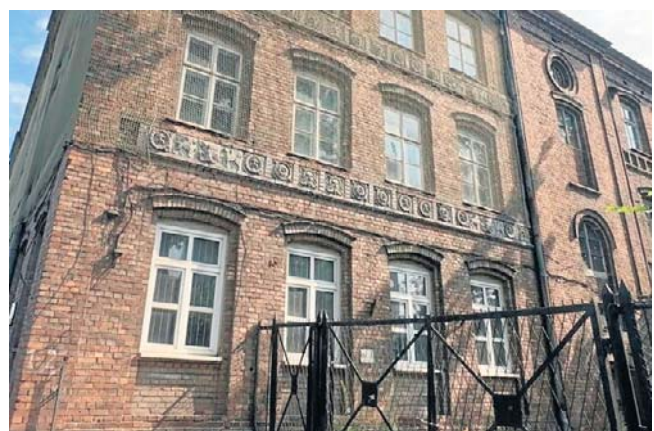
Ozdobą tego budynku są dekoracyjne kasetony pod parapetami pierwszego i drugiego piętra
