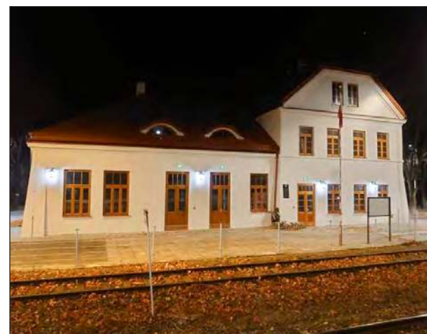
Mieszkańcy mają nadzieję, że za jakiś czas również tak będzie wyglądał budynek w Leopoldowie, jak ten bliźniaczy, parę lat temu wyremontowany w Krzywdzie
