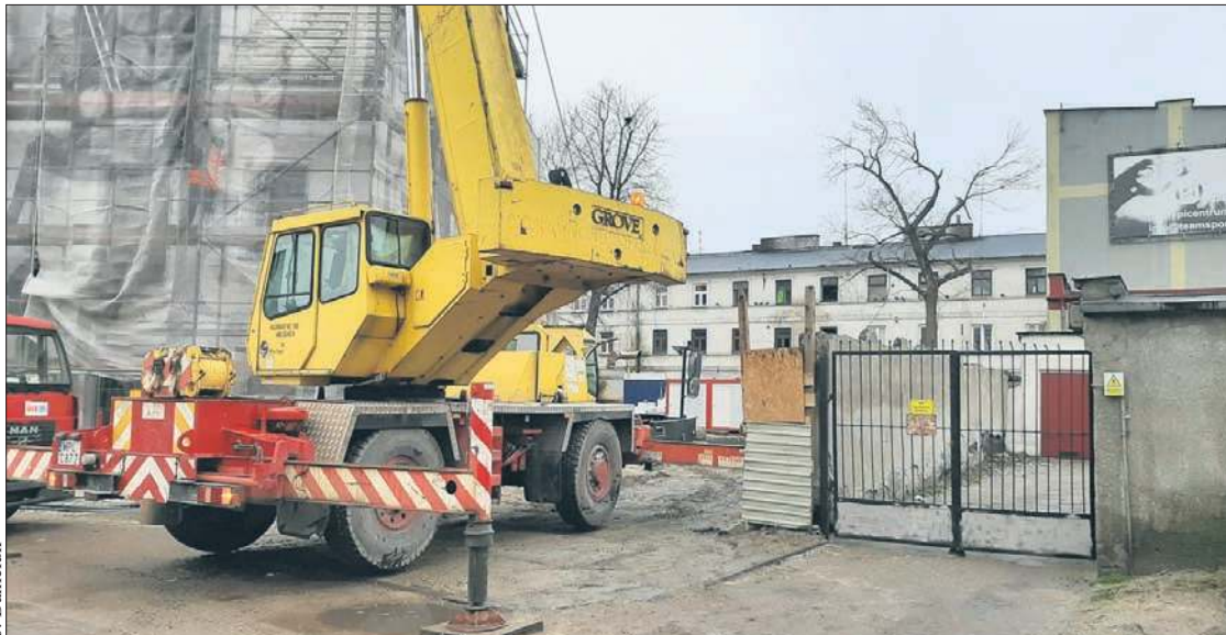
Budowa kamienicy przy ul. Sienkiewicza 44. To z nią sąsiadują przewidziane do wyburzenia oficyny
