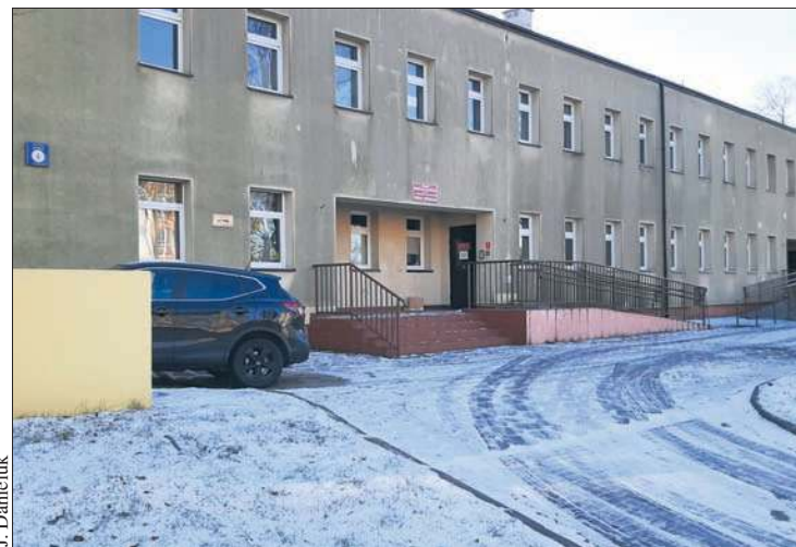
Wkrótce budynek przy ul. Mościckiego 6 zostanie przebudowany
