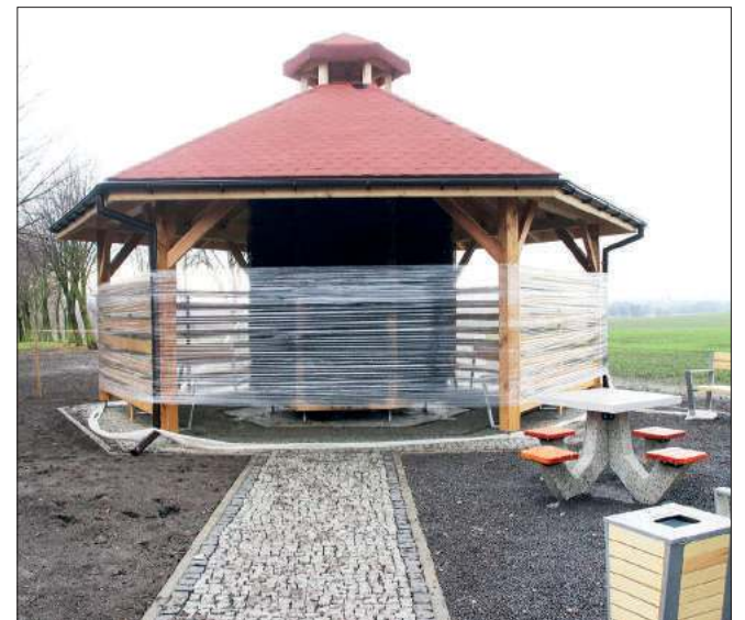
Oto tężnia, którą wybudowano w Pietrowicach Wielkich. Na razie jest jednak zamknięta.
