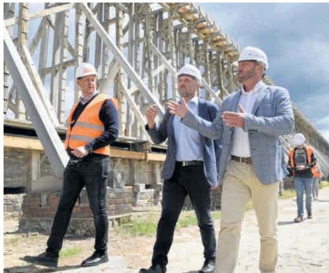
Na początku lipca prac remontowych przy tężni numer 3 doglądał Piotr Całbecki, marszałek województwa
