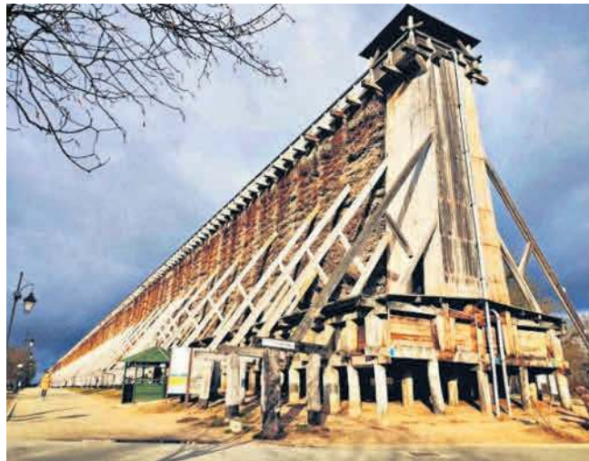
Modernizacja popularnej tężni numer 1, znajdującej się przy ciechocińskim deptaku, ruszyła w połowie września
