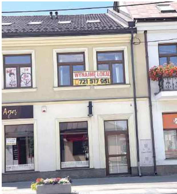
W dwóch oknach zawieszono informację o wynajmie lokalu. Budynek przy ulicy Lubelskiej
