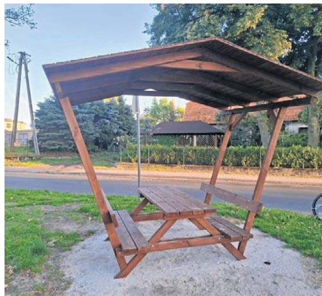
Zakres projektu obejmuje też m.in. montaż wiat w miejscach odpoczynku, nowych ławek
