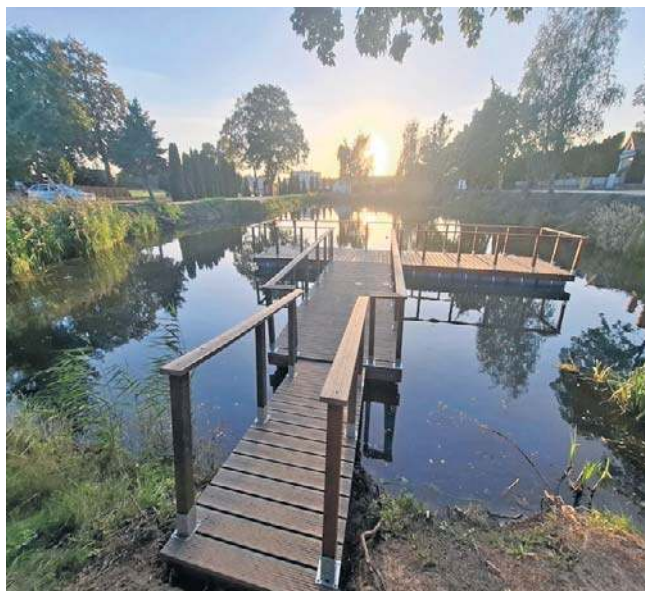
Konstrukcja pomostu jest już dobrze widoczna, ale na końcowy efekt trzeba jeszcze poczekać
