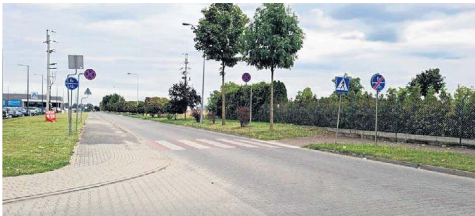
Ulica Fabryczna w Grodzisku Wielkopolskim. Gmina złożyła wniosek o dofinansowanie jej przebudowy z Rządowego Funduszu Rozwoju Dróg
