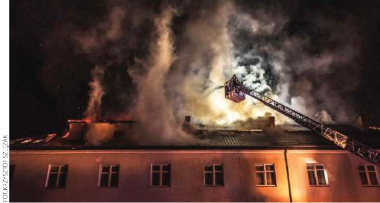
Pożar strawił budynek Domu Pomocy Społecznej im. Matki Teresy z Kalkuty w nocy z 30 na 31 sierpnia. Na szczęście w porę udało się ewakuować wszystkich podopiecznych i skończyło się na stratach materialnych. Te sięgają aż ponad 10 mln złotych
