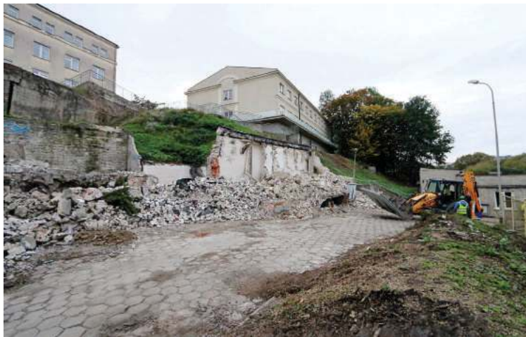
Budowa nowego bloku operacyjnego Samodzielnego Publicznego Szpitala Klinicznego nr 1 w Lublinie rozpocznie się lada dzień
