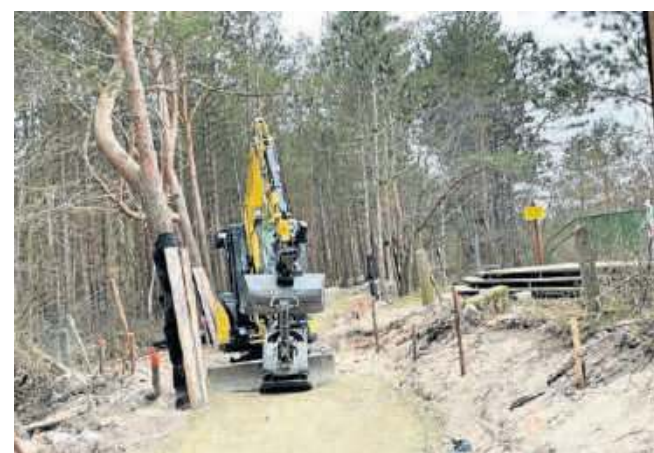
Ścieżka rowerowa budowana z Międzyzdrojów w stronę Świnoujścia właściwie jest już na ukończeniu
