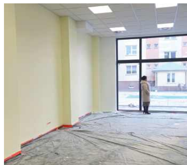
Wójt Anna Mróz w ubiegłym tygodniu wizytowała w budowanym przedszkolu w Kąkolewnicy
