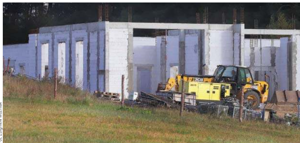
Trwa budowa wielofunkcyjnego domu przedpogrzebowego
