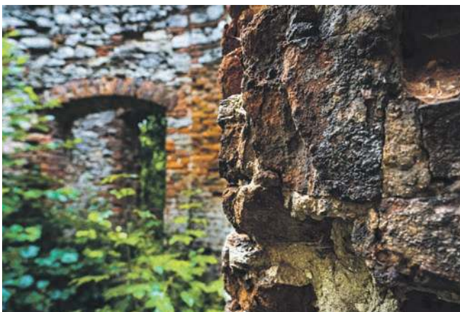
Odsłonięte mury, w których strukturze widoczny jest materiał, z którego powstał pałac – cegła i lokalny kamień
