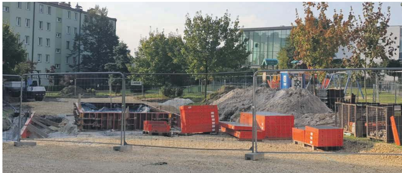
Budowa tężni na os. Północ w Chrzanowie
