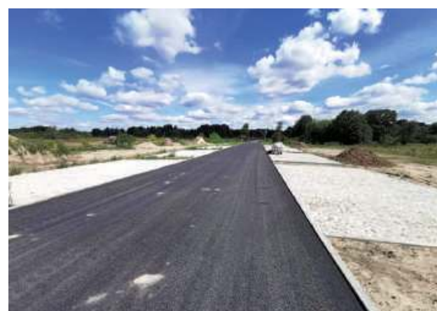
Trwają zaawansowane prace przy rzece Klukówce
