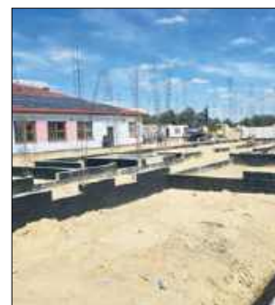
Rozbudowa ZOL-u polega na dobudowie nowego obiektu o powierzchni ponad 2300 mkw
