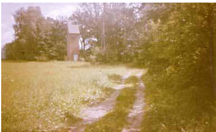
Srodkowa część Nowych Wyszomierek. Transformator, do którego dochodziła linia elektryczna z Wyszomierza. Zdjęcie z 1996 r.
