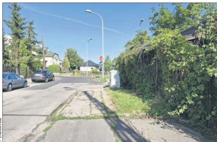
Część ulicy Lasockiego wymaga remontu
