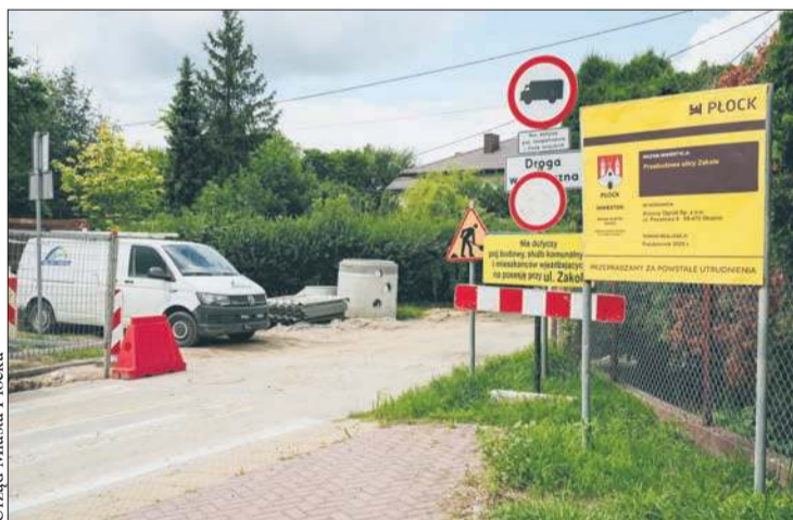
Trwa budowa ulic Zakole w Borowiczkach i Wiosennej w Imielnicy
