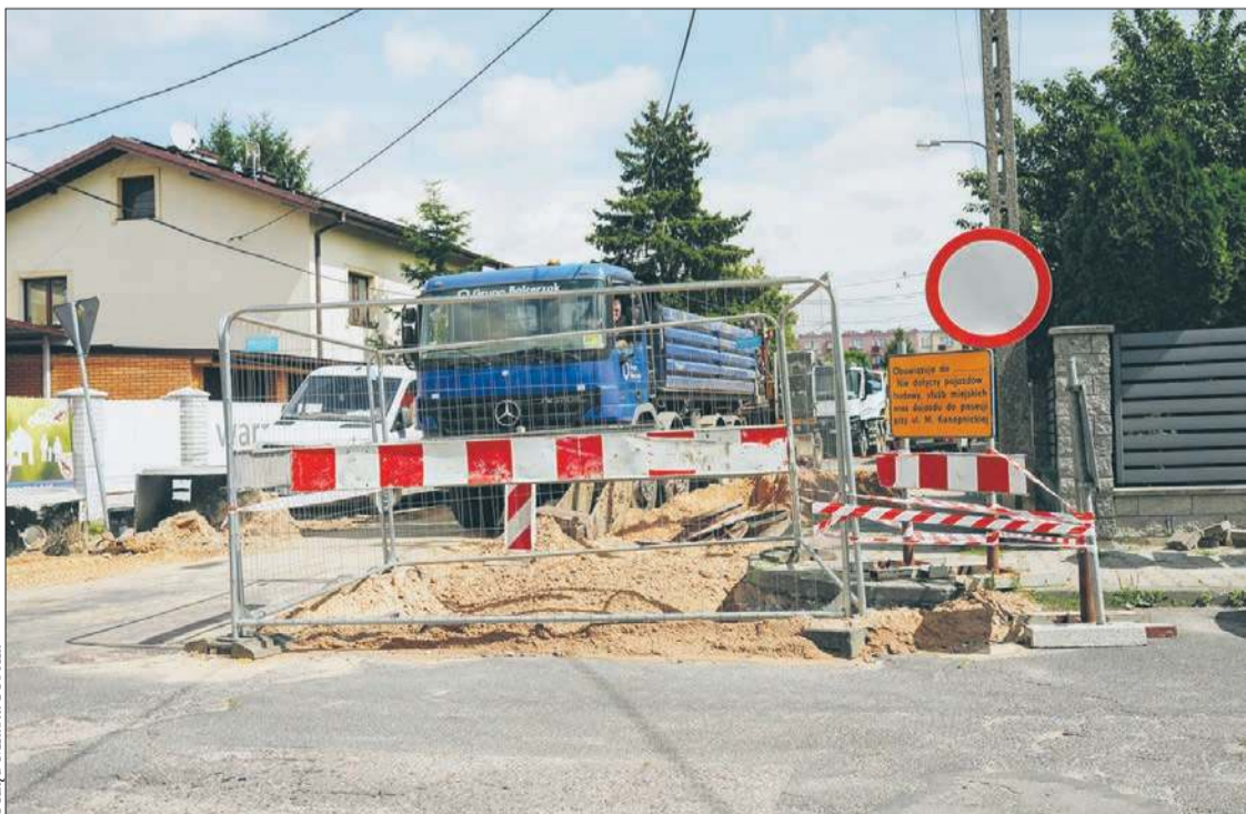
Trwa budowa ulicy Konopnickiej na osiedlu Skarpa
