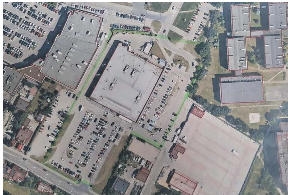
Widok na targowisko przy ul. Szpitalnej w Chrzanowie (na dole po prawej), obok - otoczony zieloną linią teren należący do Netto (sklep i parkingi). Pomiędzy nimi droga gminna; na dole ul. Szpitalna, fot. Geoportal Chrzanów
