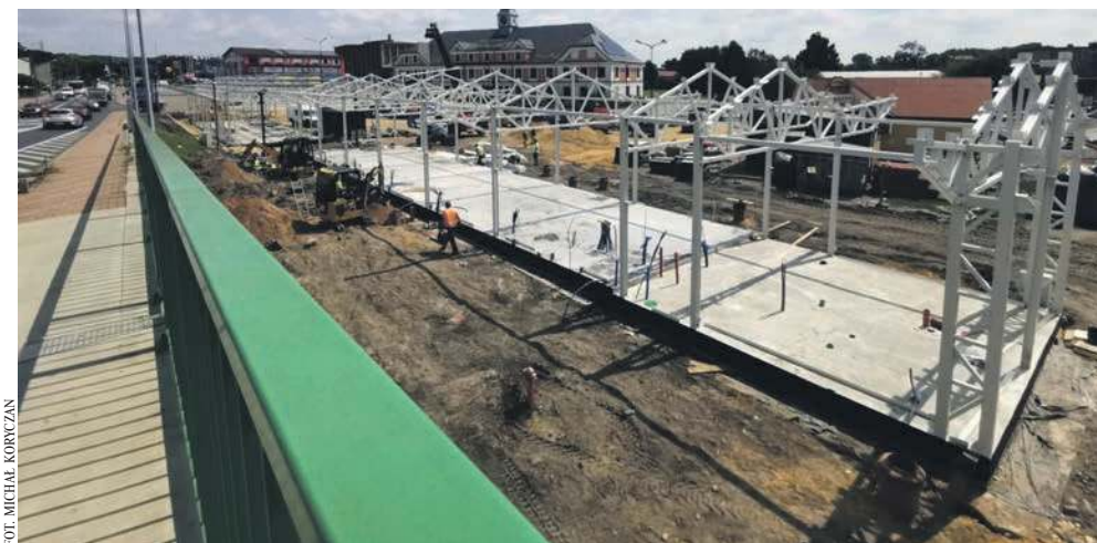
Widok na powstające pawilony
