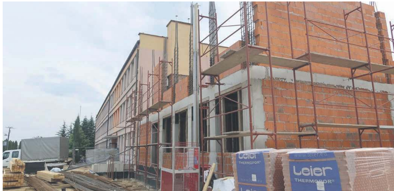
Rośnie budynek przedszkola, dobudowywany do szkoły w Żarkach
