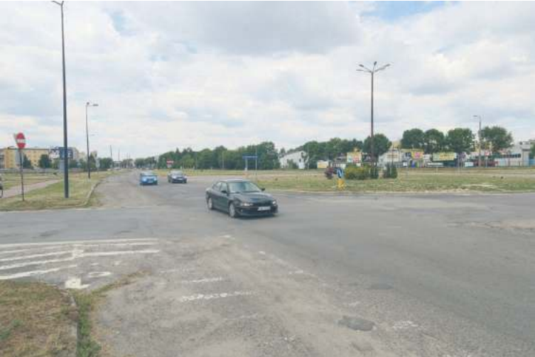
II etap przebudowy ul. Raclawickiej obejmuje odcinek od ul. Kosynierów do skrzyżowania z al. Armii Krajowej i ul. Kusocińskiego, gdzie powstanie rondo
