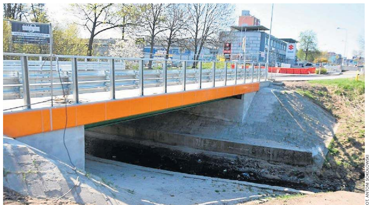
Tak prezentuje się gotowy już most nad Potokiem Północnym w ciągu ulicy Chrobrego w Radomiu.
