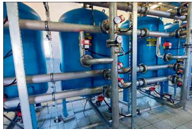
Instalacje w stacji uzdatniania wody w Nowym Budzie zostały wymienione.
