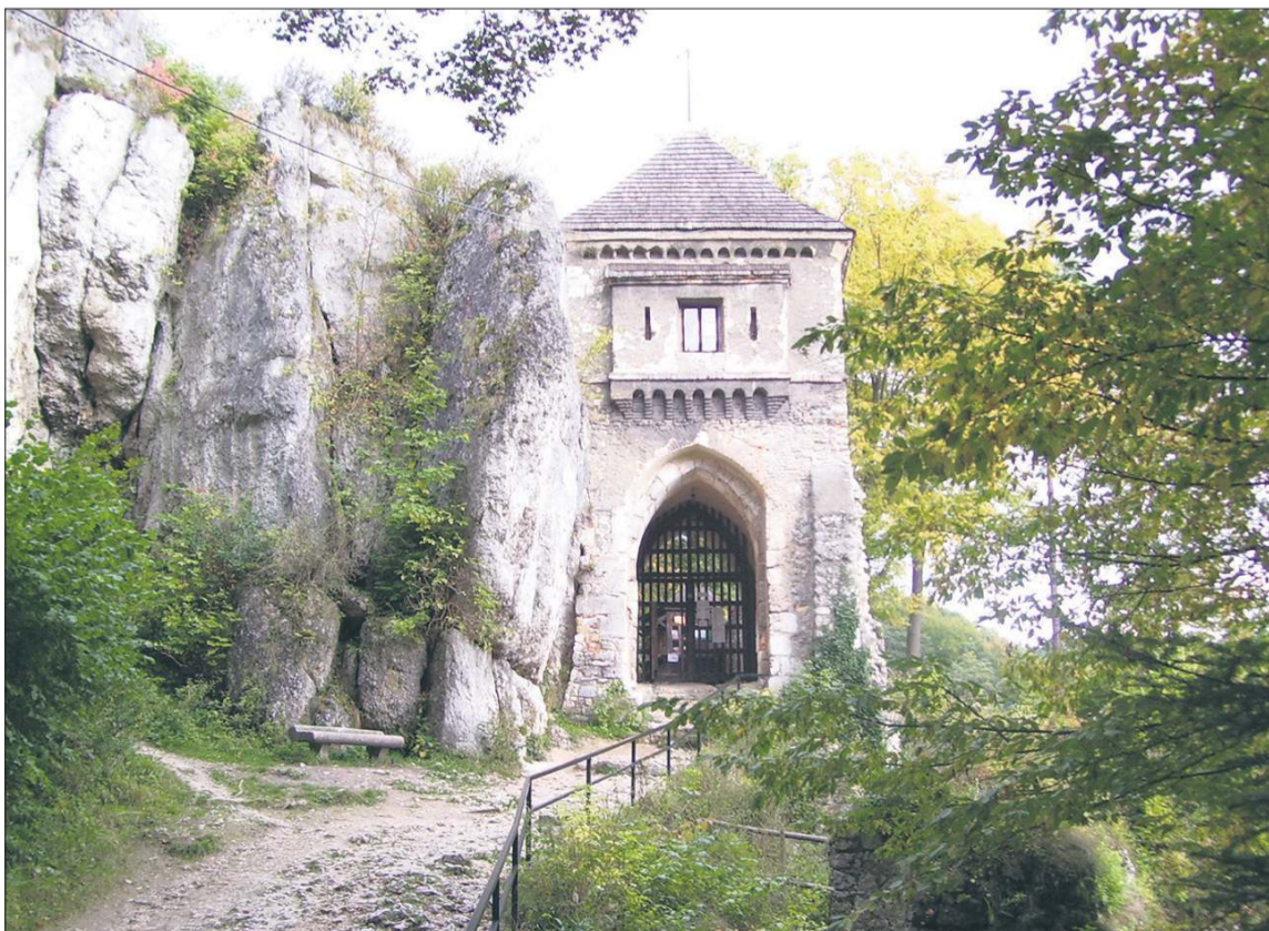
Wieża bramna z przylegającymi do niej wapiennymi ostałkami skalnymi
