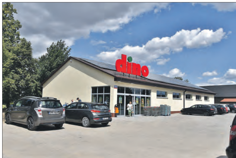
Sklep w Lubrzy znajduje się przy wjeździe od strony Prudnika
